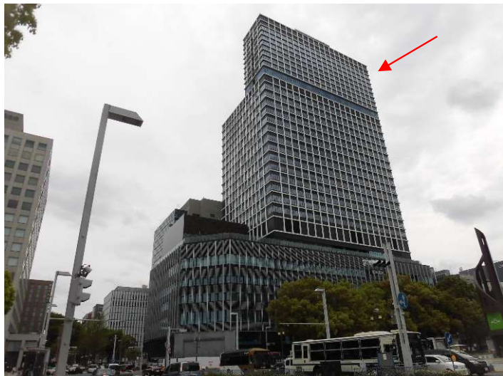
中日ビル建替(施工中)
