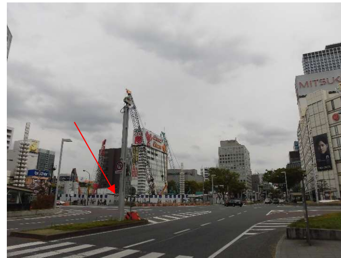
栄広場の再開発(施工中)
