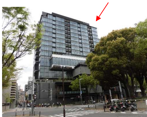
「TIAD」(ティアド)(施工中)
