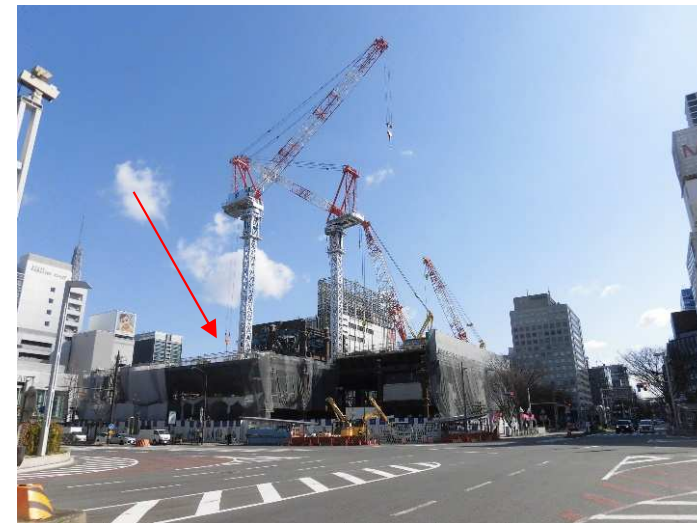
栄広場の再開発(施工中)
